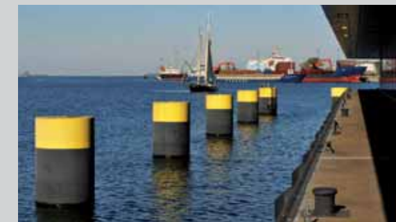
Technologie und Gewerbezentrum Wismar Hafen
