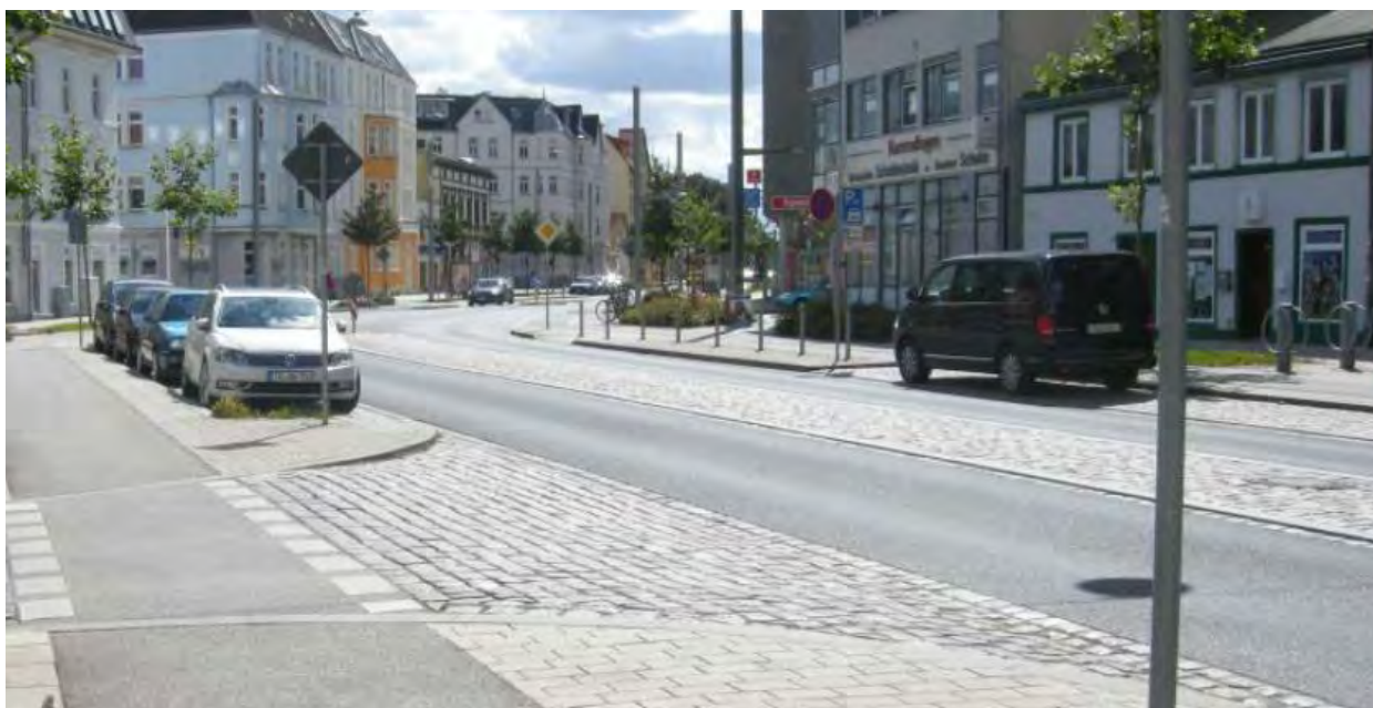
Frankendamm nach der Sanierung - Haupterschließungsstraße zur historischen Altstadt
